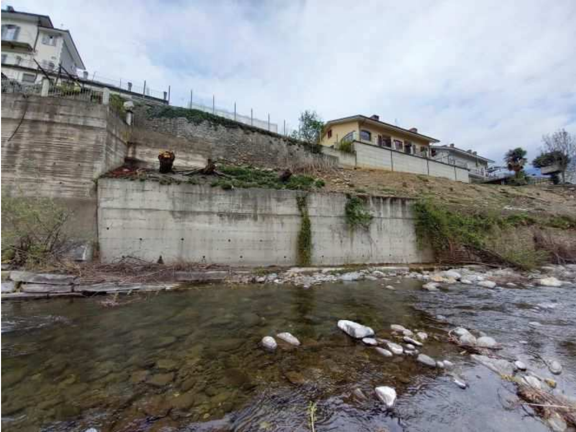
Foto 1: foto storica dell'anno 202 del muro in c.a. completamente ribaltato dall'evento alluvionale del 17 aprile 2025
