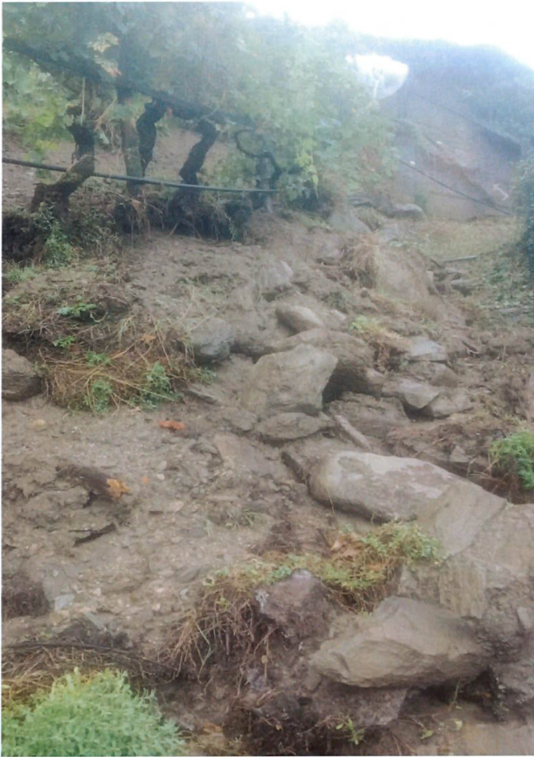
Foto 1 dissesto con crollo del muro
