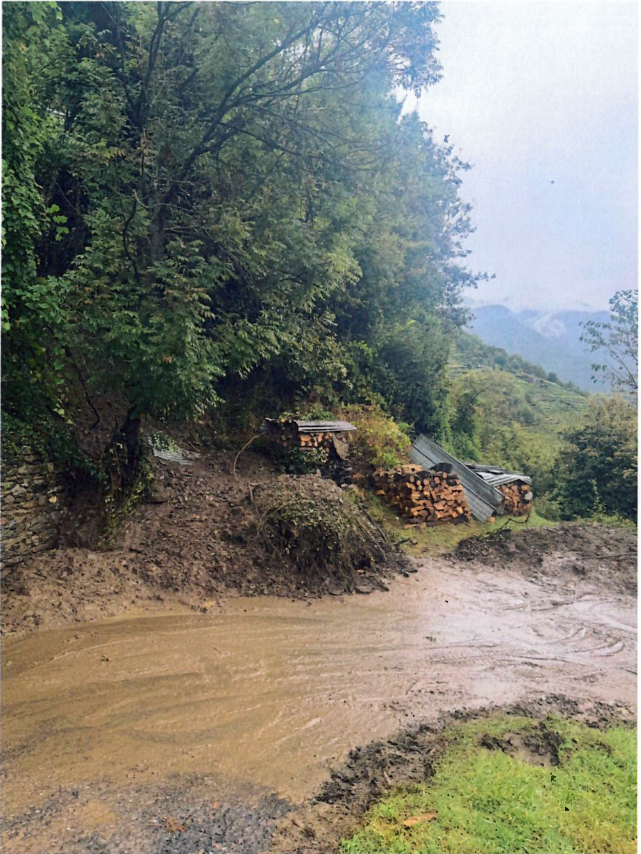
Foto 1 sedime stradale parzialmente invaso
