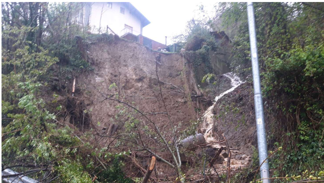
Sito del dissesto principale
